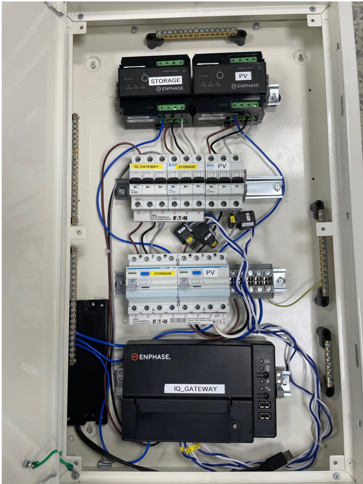
Abbildung 11 Endgültige Montage der AC Combiner Box
