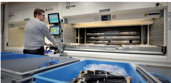
Hohe Verfügbarkeit dank automatischem Kleinteilelager
